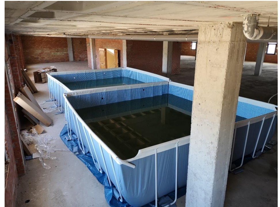
Prueba de carga para instalación de equipos en planta 3º del edificio de EGUSA ubicado en la calle dels Calderers, nº86-88 (Alboraya) [Valencia].
