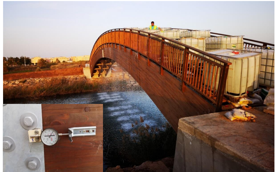
Prueba de carga de pasarela peatonal de madera en la desembocadura del Río Belcaire en el término municipal de Moncófar (Castellón).
