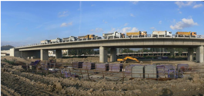
Prueba de carga de viaducto en la entrada sur de la localidad de Annaba (Argelia)
