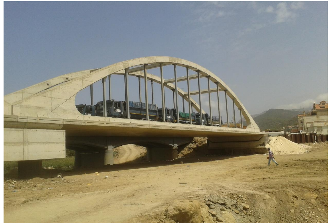
Prueba de carga en puente de Sur Oued Allala Sur RN11 AU PK203+824 de la localidad de Tenes (Argelia).
