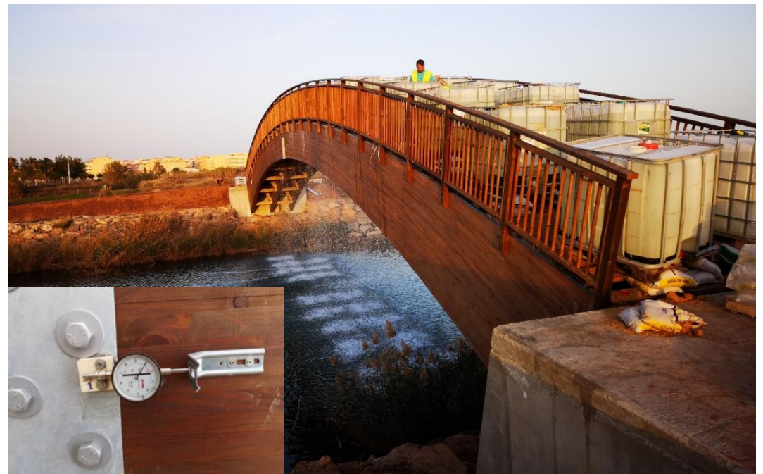
Prueba de carga de pasarela peatonal de madera en la desembocadura del Río Belcaire en el término municipal de Moncófar (Castellón).
